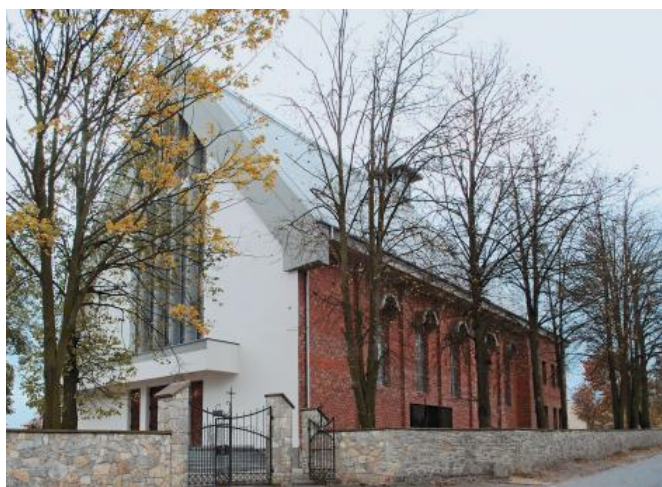
Rys. 7 Kościół parafialny pw. Św. Rozalii w Skorzeszycach 6
