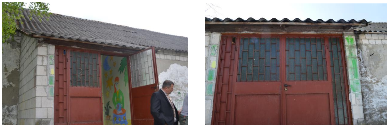
Rys. 13 Świetlica w Napękwie – elewacja północna
